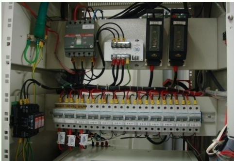
ติดตั้งที่สถานีรถไฟ MRT
